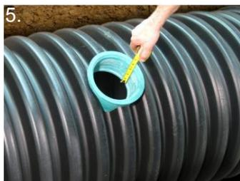
5. Mesurez la profondeur du QwikSeal, de la butée du tuyau au bord supérieur.
