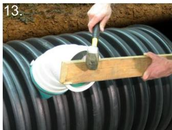
13. Installez le raccord de tuyau. Le raccord doit être aligné avec la surface du QwikSeal.
