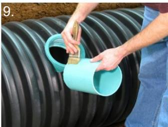
9. Lubrifiez le QwikSeal et le bout de tuyau.
