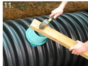
11. À l'aide d'un marteau et d'un bloc de bois, enfoncez le bout de tuyau jusqu'à la butée de tuyau QwikSeal.
