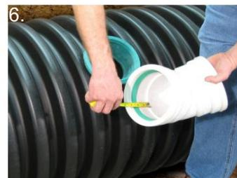
6. Mesurez la profondeur du raccord à fixer au bout de tuyau. Voir la méthode alternative ci-dessous.
