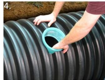
4. Tirez sur QwikSeal jusqu'à ce qu'il s'arrête contre l'intérieur du tuyau.
