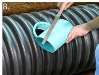
8. Biseauter le bord d'attaque du bout de tuyau pour faciliter l'insertion dans le QwikSeal.
