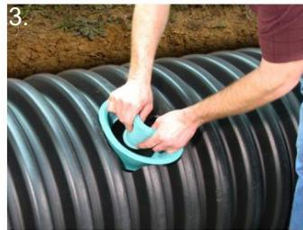
3. Retirez le collier de serrage du QwikSeal, pliez-le et insérez-le dans l'ouverture. Se dérouler.
