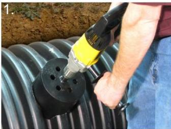
1. Percez un trou perpendiculaire à la ligne principale : - Trou de 5" pour entrée de tuyau de 4" - Trou de 7" pour entrée de tuyau de 6" - Trou de 9" pour entrée de tuyau de 8"
